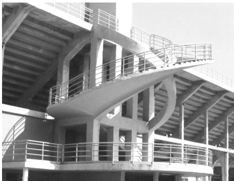
La bella e ardita rampa aerea di accesso
